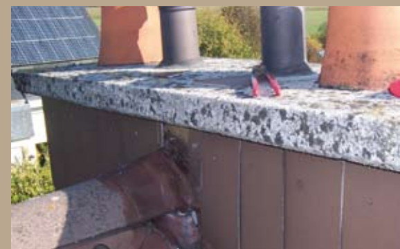
Durch das Abdichten des Kamins wurde verhindert, dass weiterhin Kot auf den Speicher fällt.
