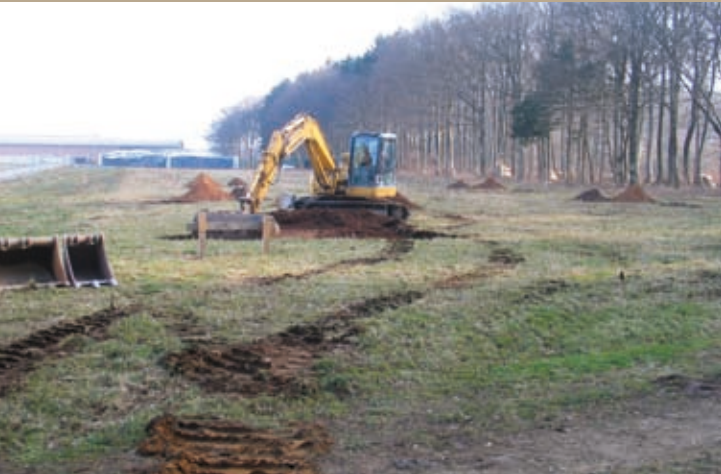
Februar 2011: die Terrassierungsarbeiten beginnen
