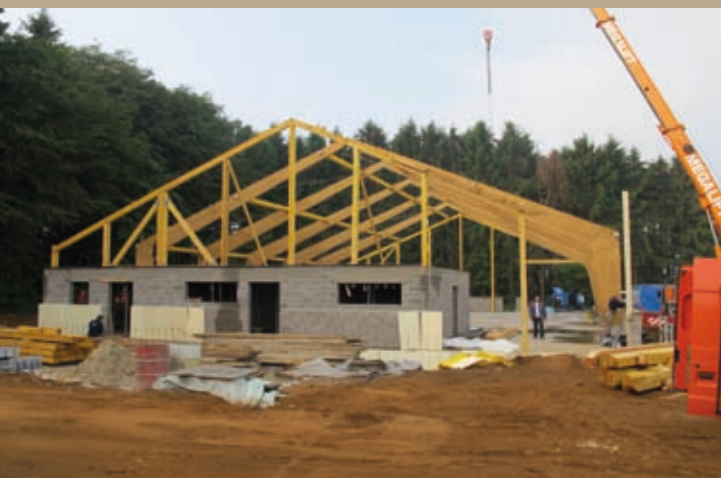
Die Holzfertigbaukonstruktion steht
