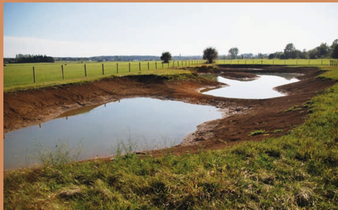
Nach einem ersten Projekt im Jahr 2011 wurde in diesem Jahr die Optimierung des Europäischen Vogelschutzgebietes „Oberes Alzettetal“ in der Gemeinde Roeser mit der Anlage eines weiteren Altarms von 150 m Länge auf Gemeindeparzellen fortgesetzt.
