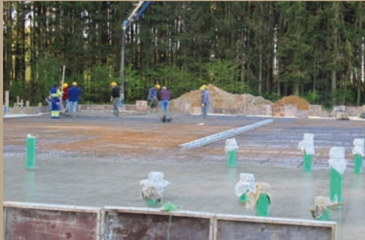
Betonierung der Grundplatte
