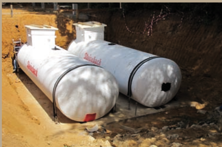
Die Treibstofftanks werden eingebaut
