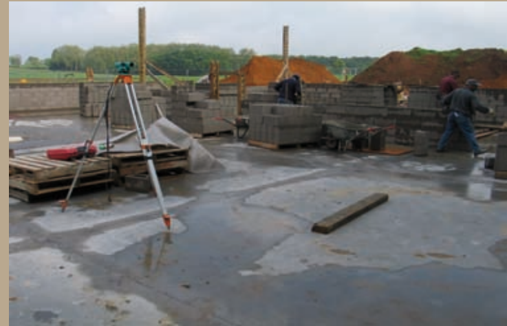
Errichten des Sanitär- und Aufenthaltsblocks
