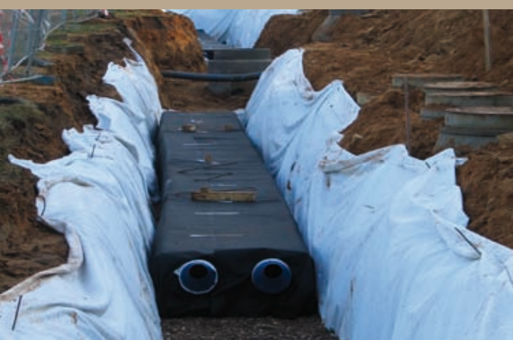
Überschüssiges, sauberes Oberflächenwasser wird über spezielle Sickerblöcke versickert
