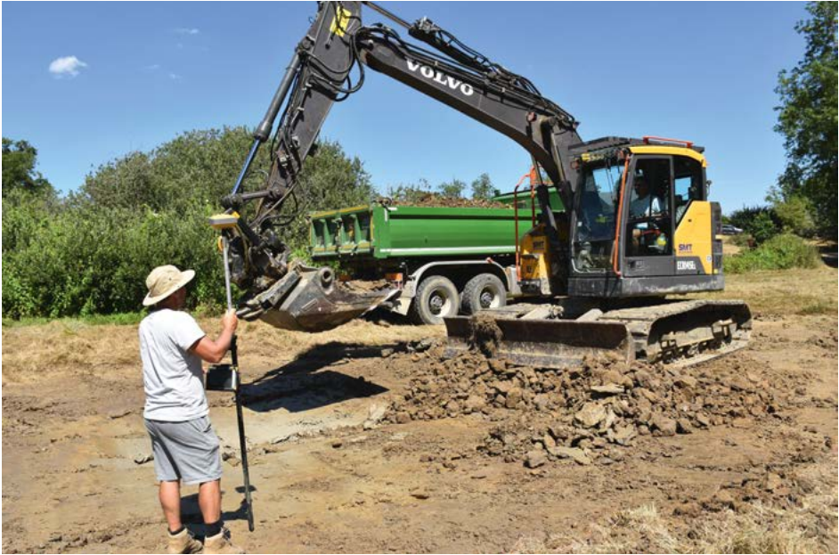
Abb. 18. Mit Baggern werden Stillgewässer ausgehoben oder Feuchtgebiete renaturiert und das Bodenmaterial mittels LKW's abtransportiert – und das oft in großem Umfang (Foto: SICONA).
