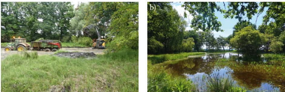
Abb. 38. 38a: Je nach Entwicklung ist nach vielen Jahren eine aufwendigere Pflege und Entschlammung der Gewässer notwendig. 38b: Knapp zwei Jahre nach dem Ausbaggern hat sich bereits wieder eine lebensraumtypische und artenreiche Vegetation entwickelt (Fotos: SICONA).
