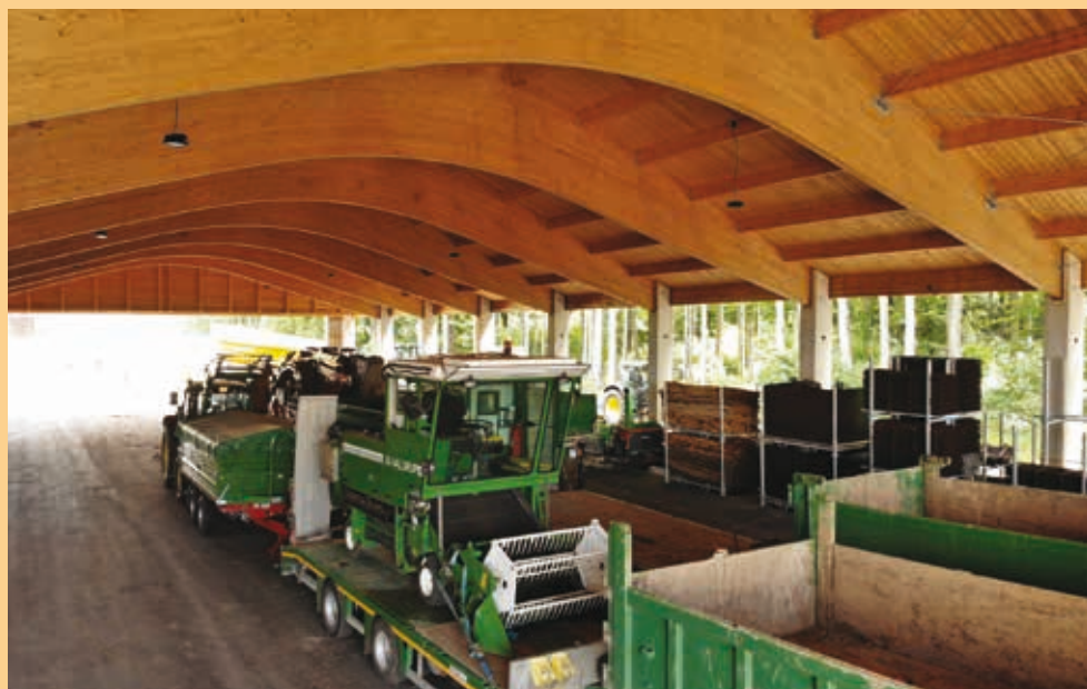
Aus Klimaschutzgründen wurde ganz bewusst auf eine Holzkonstruktion gesetzt, denn Holz speichert CO 2 , wohingegen bei der Herstellung von Stahl CO 2 entsteht. Aber auch Sicherheitsgründe sprachen für eine Holzkonstruktion, da Holz beständiger in einem Brandfall ist als Stahl.
