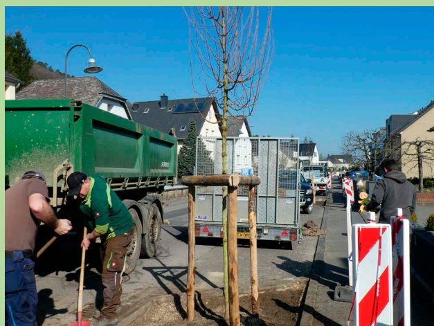
Gemeinde Lintgen: Gosseldange 'Route de Mersch' – Bepflanzung von 10 Straßeninseln mit Bäumen sowie Ansaat der Baumscheiben mit der Mischung LUX-Schotterrasen auf Kalksplittsubstrat.
