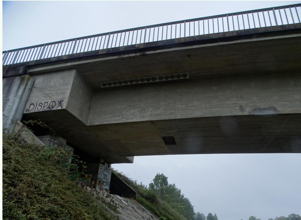
Nids artificiels en-dessous d'un pont
