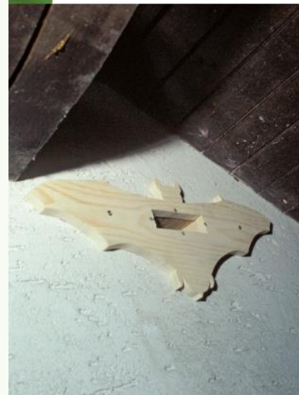
Einflugöffnung für Fledermäuse am Giebel eines Hausneubaues.
