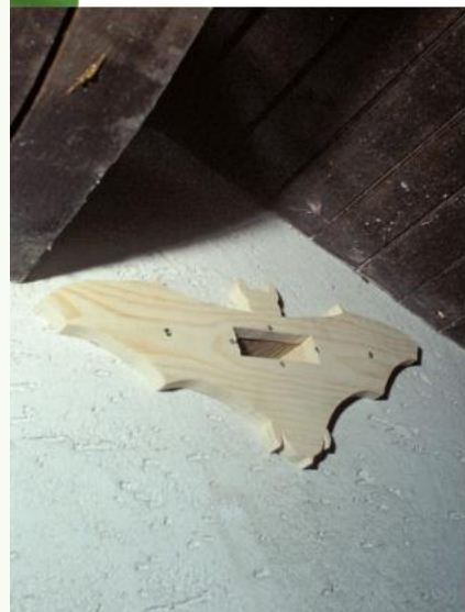
Einflugöffnung für Fledermäuse am Giebel eines Hausneubaues.
