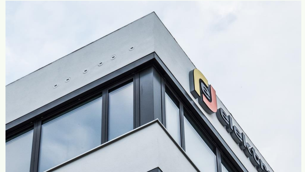
Nistkästen für Gebäudebrüter lassen sich optisch unauffällig in die Fassade integrieren.
