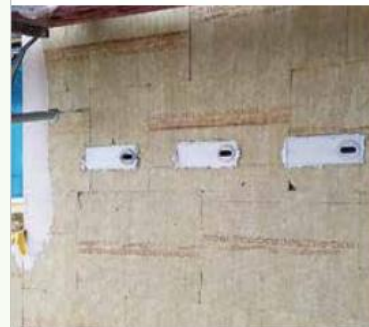
Die Kästen können problemlos in die Wärmedämmung eingebaut werden.
