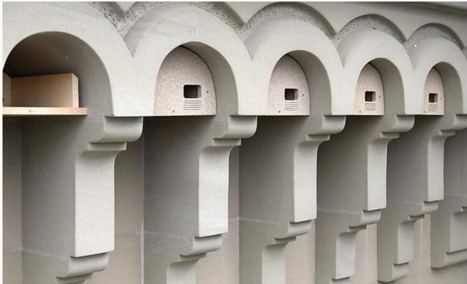
Bundeshaus Bern: Mauersegler sollen sich am Bundeshaus einnisten
